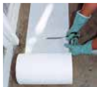
2. Triflex Spezialvlies-zuschnitte vorbereiten.
