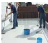
11. Die Versiegelung Triflex Cryl Finish 205 auftragen und mit Quarzsand abstreuen.
