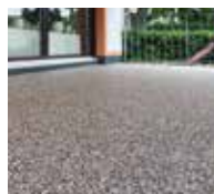
15. Fertig ist die Triflex Stone Design-Fläche.
