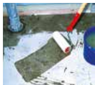
1. Wandanschluss und Fläche grundieren.
