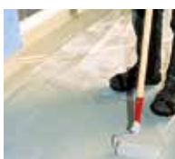
9. Eine zweite Schicht Triflex ProTerra wird aufgebracht.
