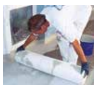
8. Das Triflex Spezialvlies wird vollflächig und blasenfrei eingearbeitet.
