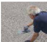
14. Mit einer venezianischen Kelle verdichten und mit einer Glättkelle glätten.
