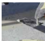
10. Profilschienen mit Triflex Cryl Spachtel einkleben.
