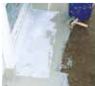
4. Das Triflex Spezialvlies wird vollflächig und blasenfrei eingearbeitet.
