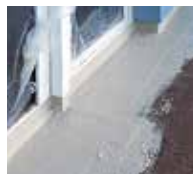
5. Eine zweite Schicht Triflex ProDetail wird aufgebracht.
