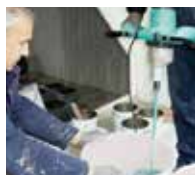
12. Triflex Stone Design S und Triflex Stone Design R 1K mischen.
