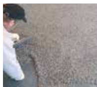
13. Zuerst werden die Aufkantung, dann die Fläche erstellt.
