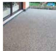
**Triflex Stone Design** è impiegato su spazi utilizzati o superfici con particolari esigenze estetiche ed è in grado di tollerare elevate sollecitazioni meccaniche. In combinazione con l'impermeabilizzazione armata con tessuto non tessuto Triflex ProTerra, offre all'edificio una protezione a lungo termine.
